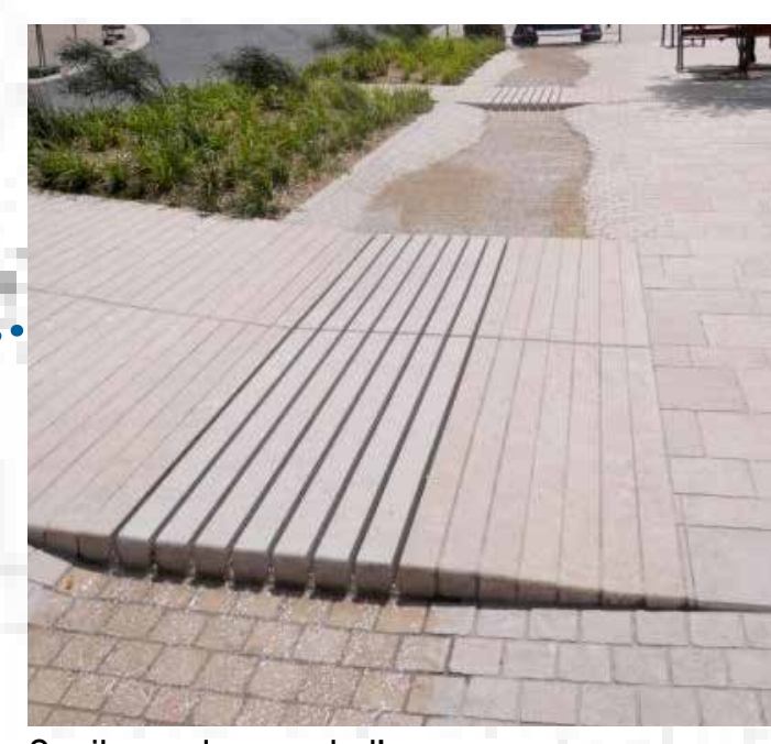
Seuils au-dessus de l'eau
