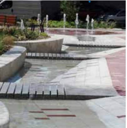
Passages au-dessus du chemin d'eau
